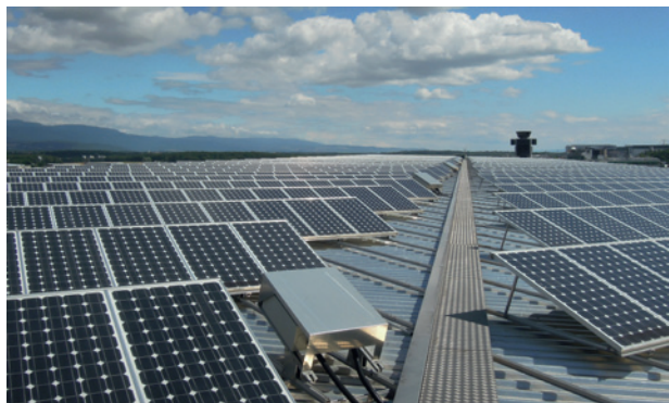
Installation de 280 kW sur le Grand Hangar à Genève
