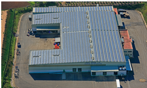
Installation de 913 kW Huelva à Gibraleón
